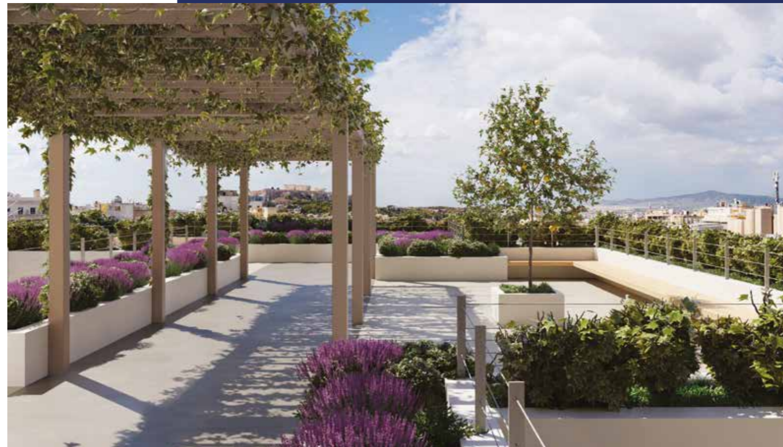
Το κτίριο αναμένεται να αναβαθμιστεί αισθητικά και ενεργειακά, συμβάλλοντας στην προσπάθεια συνολικής αναβάθμισης του κέντρου της Αθήνας
