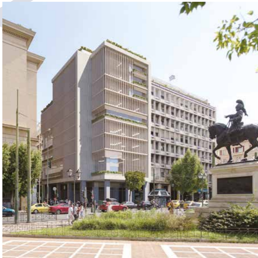
Ανακαίνιση κτιρίου γραφείων που βρίσκεται στη συμβολή των οδών Ομήρου & Σταδίου
